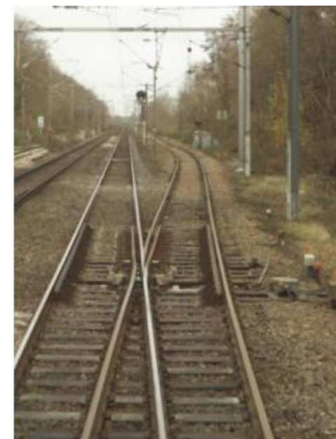
Appareil de voie à remplacer
